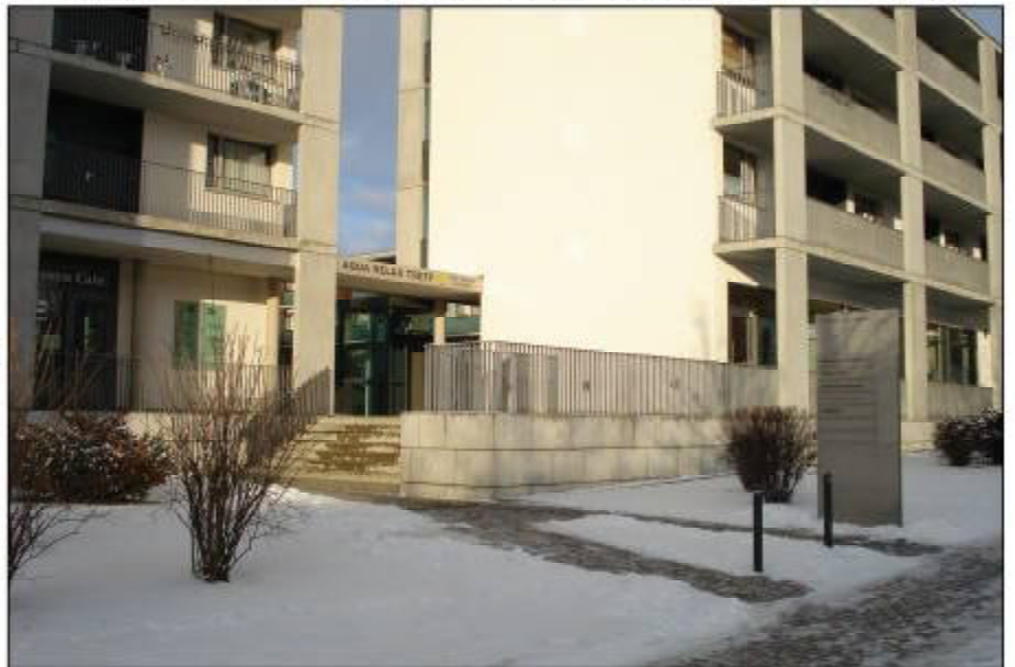
Blick auf das zwischen Ettersburger Straße und Allstedter Straße geschaffene Wohn- und Seniorenzentrum der GWG mit seinem Dienstleistungsbereich einschließlich Terrassencafé
