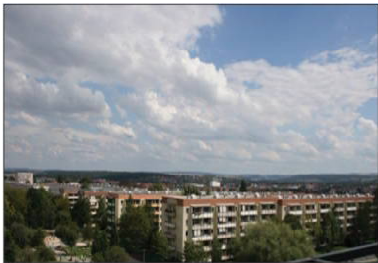
Blick auf den westlichen Teil des 2. Bauabschnitts
