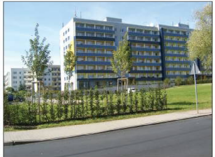
Apartmenthaus Bonhoefferstraße 48/50 nach der Sanierung im Jahre 2007
