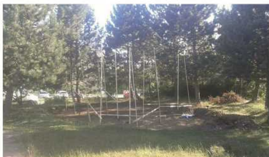
Bild 11: Die Arbeit am neuen Klettergerüst beginnt
